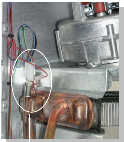
Termostat siguranta tur (STB) si Senzor temperatura tur (NTC)
