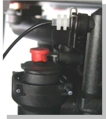
Aerisor automat montat pe pompa
