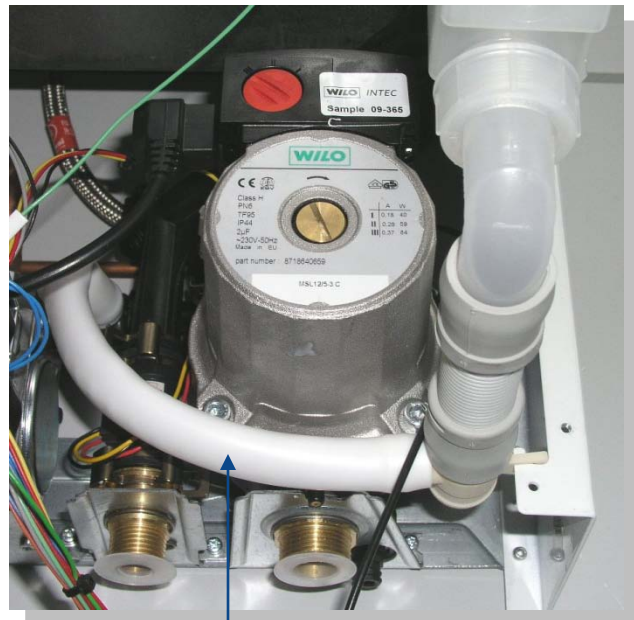
Furtun scurgere pentru supapa de siguranta si sifonul pentru condens
