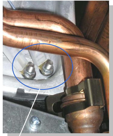
Senzor nivel condensat
